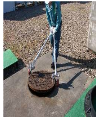
④工具を押し下げ手前に引く
