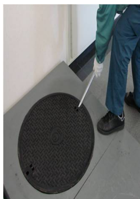
①付属のコジリ棒(もしくは地切り工具)にて鉄蓋の地切りを行う
