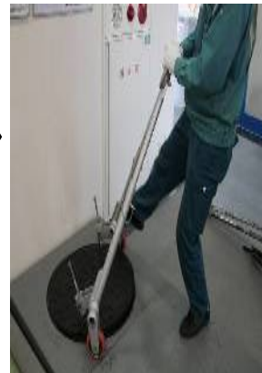
④左方向に回転させ、鉄蓋のロック解除する
