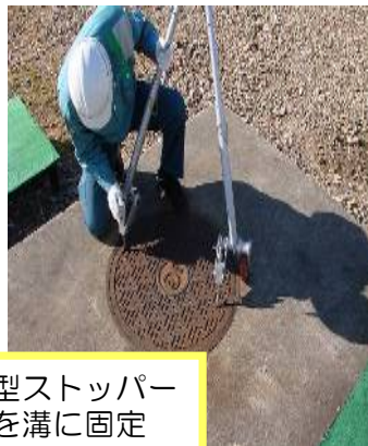
③ T型フックを90度回転させてT型ストッパーを溝にロックする
